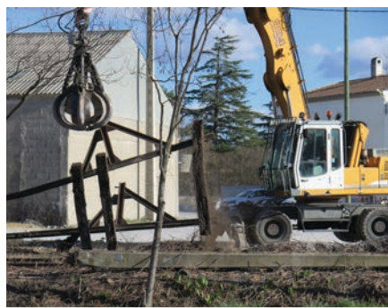
Enlèvement des rails
